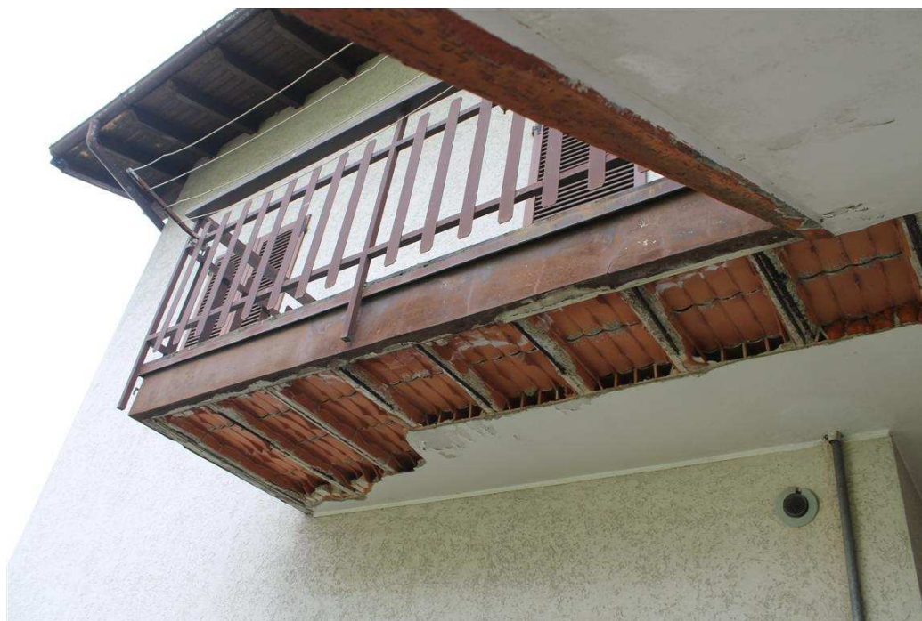
FOTO 1: Balcone ovest - intradosso
