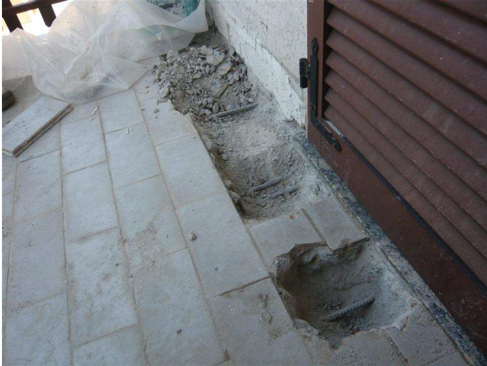
FOTO 8: Balcone ovest – estradosso: rilievo delle armature (1d10 + 2d10 + 1d10 + 2d10)
