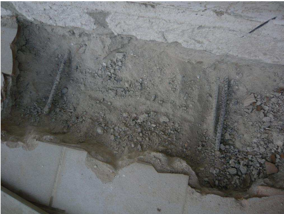
FOTO 7: Balcone ovest – estradosso: rilievo delle armature (1d10 + 2d10)
